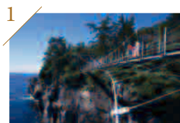
城ヶ崎門脇つり橋
